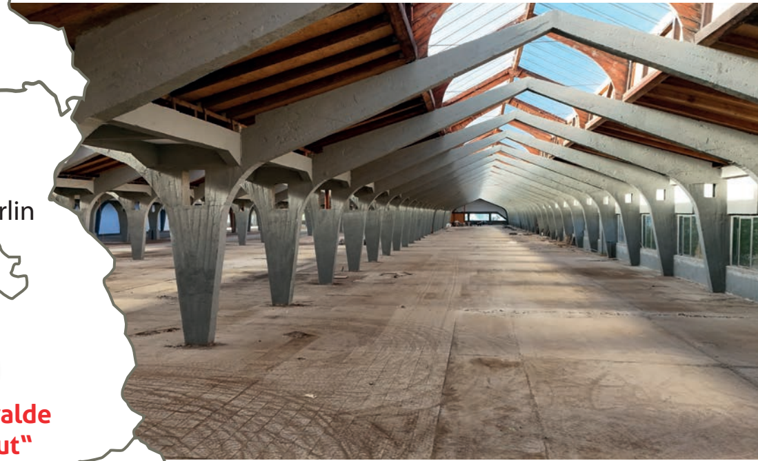
INNENAUFNAHME DER MENDELSONNHALLE IN LUCKENWALDE
